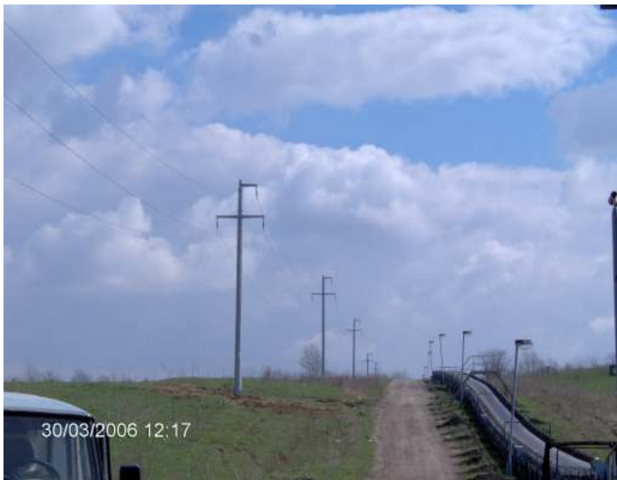
Slika 1. Izgled dela trase 35 kV nadzemnog voda
