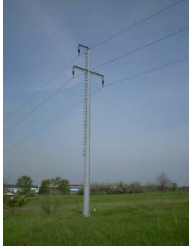
Slika 3. Izgled stuba 35 kV nadzemnog voda
