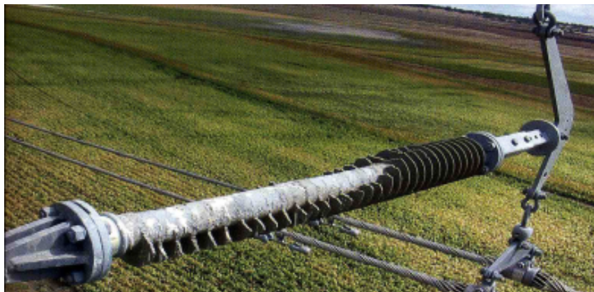
Slika 2 – Drastičan primer oštećenja od ptica [3]
