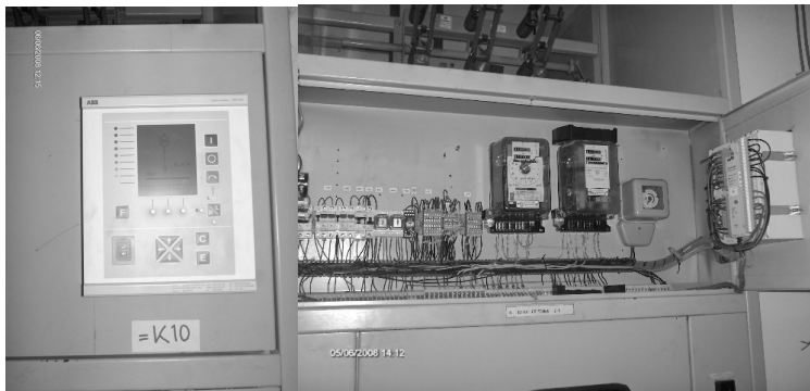
Слика 20 и 21 : МПЗУ и изглед ожичења
