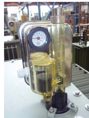
Slika 15. Kombinirani zaštitni uređaj
