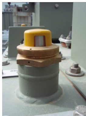
Slika 13. Magnetski uljokaz
