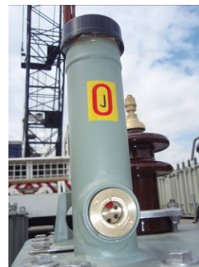
Slika 14. Optički uljokaz
